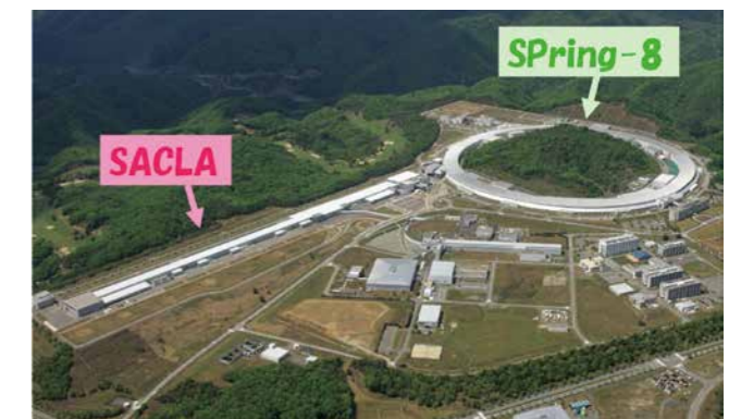
大型放射光施設(SPring-8)(右:円形の施設) X線自由電子レーザー施設(SACLA)(左:直線状の施設)(提供:理化学研究所)
