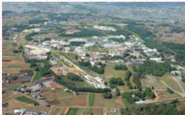
高エネルギー加速器研究機構(KEK)の空撮写真(提供: KEK)
