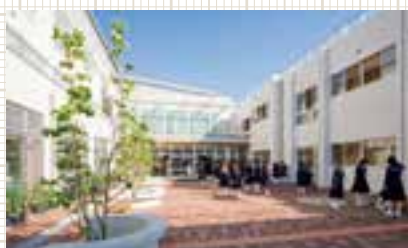
老朽化した古い校舎を良好な教育環境に改修(「学校施設の老朽化対策について平成25年3月学校施設の在り方に関する調査研究協力者会議」より)
