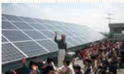
校舎屋上に太陽光パネルを設置し、発電した電力を活用するとともに、環境教育の教材として活用
