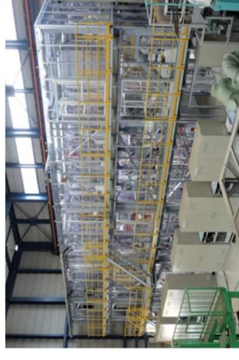
連続水素製造試験装置
