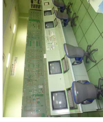
ガラス固化処理施設の工程制御装置 (核燃料サイクル工学研究所)
