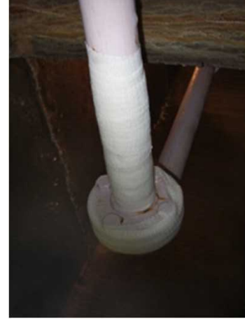
濃縮工学施設の廃水配管の補修状況 (人形峠環境技術センター)
