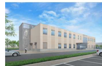
廃炉国際共同研究センター(CLADS) 「国際共同研究棟」(平成29年3月竣工予定)
