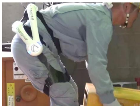
ロボットスーツを着用し資材を持ち上げる作業 提供：株式会社大林組
