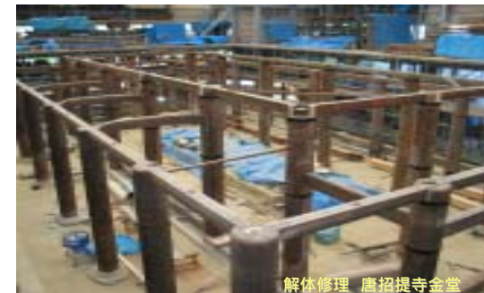
解体修理 唐招提寺金堂
