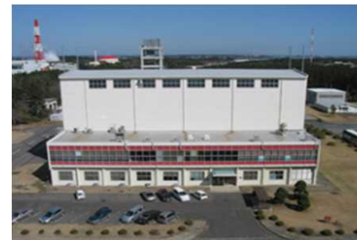
ナトリウム流動伝熱試験室(危険物施設)の耐震化対応(耐震改修) (大洗研究開発センター)
