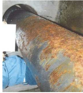
屋外配管外面腐食補修対応 (原子炉廃止措置研究開発センター)
