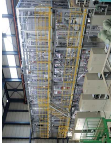
連続水素製造試験装置
