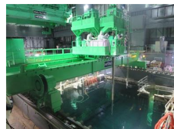
4号機の使用済燃料プールからの燃料の取り出し
