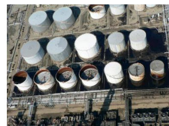
被災した石油コンビナート 提供：消防研究センター
