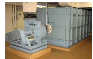
気体廃棄設備機器の保全 (原子力科学研究所)
