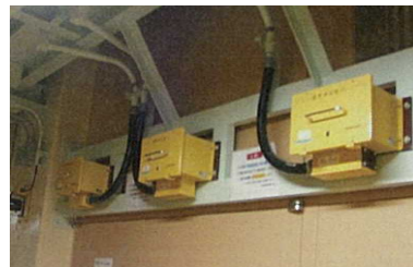
プルトニウム燃料製造施設の 臨界警報装置の更新 (核燃料サイクル工学研究所)
