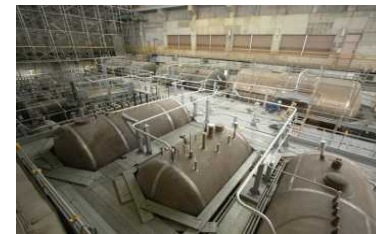
老朽化ナトリウムタンクの解体撤去 (大洗研究開発センター)
