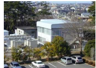
中央変電所建家(原科研)
