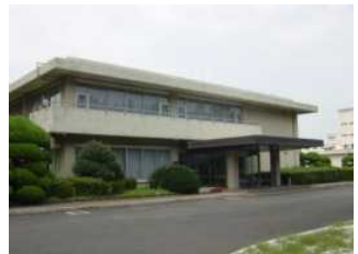
事務本館(大洗センター)
