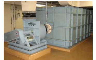
気体廃棄設備 (チェンバ型フィルタ装置)
