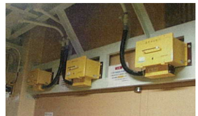
プルトニウム燃料製造施設の 臨界警報装置 (核サ研)
