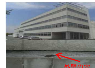
外壁の劣化による雨漏りは内部の研究機器の劣化につながる。
