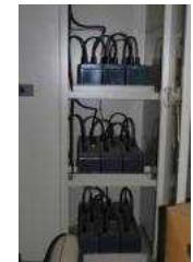
バッテリーの更新時期を大幅に超過している非常用電灯設備
