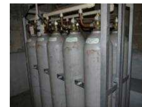
ポンプ等の交換を要する ハロゲン化物消火設備
