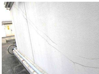
ひび割れた外壁の改修
