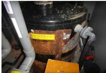
排水処理設備の更新
