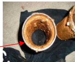
錆で詰まった 空気調和機の配管
