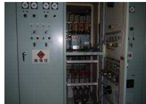
更新が必要と指摘されている 高圧コンデンサ
