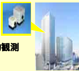
建物への地震観測システムの設置
