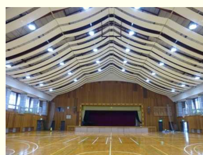
（軽量の）膜天井を設置
