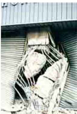
柱せん断破壊
