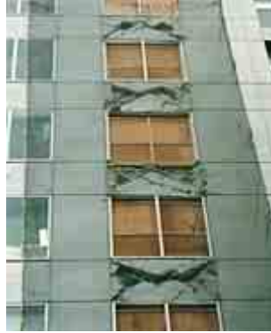
梁せん断破壊
