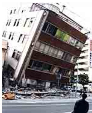
柱壁破壊による1階の崩壊
