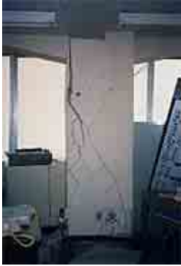
柱せん断破壊
