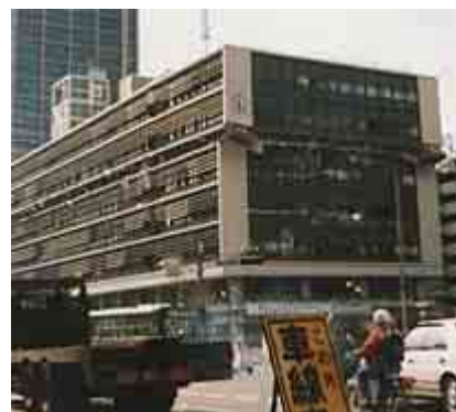
柱破壊による中間階の崩壊
