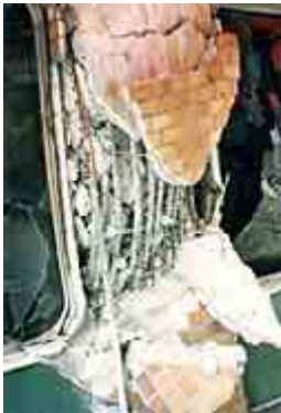
柱せん断破壊
