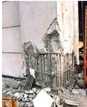
柱付着割裂破壊
