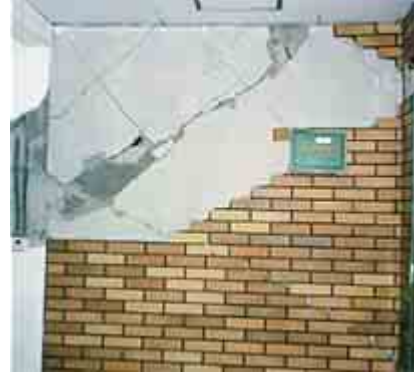
壁せん断破壊
