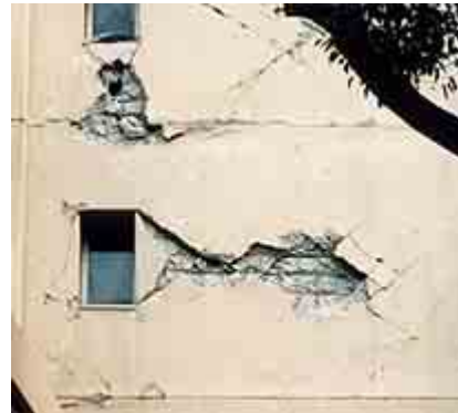
壁せん断破壊
