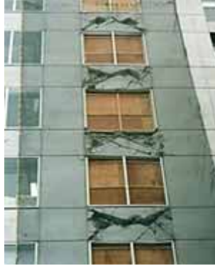
梁せん断破壊
