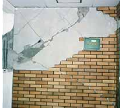
壁せん断破壊
