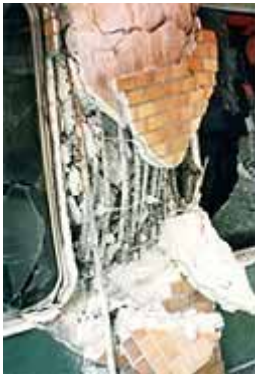
柱せん断破壊
