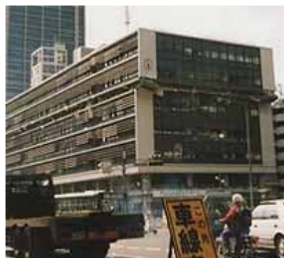
柱破壊による中間階の崩壊
