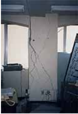
柱せん断破壊
