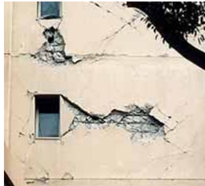
壁せん断破壊
