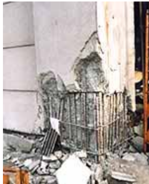
柱付着割裂破壊
