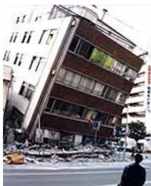
柱壁破壊による1階の崩壊
