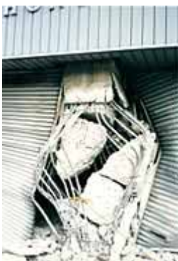
柱せん断破壊
