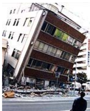
柱壁破壊による1階の崩壊
