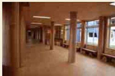
樹齢 65 ~ 95 年のスギ丸太 500 本を通し柱や登り梁に活用。2 ~ 4 m おきに連立しているスギ丸太により、特徴的な空間が構成されている。
