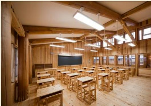
スギ丸太の登り梁を採用し、そのまま見せる仕上げとなっている。子どもたちも、どのような構造でできているのかが一目瞭然に確認できる。
