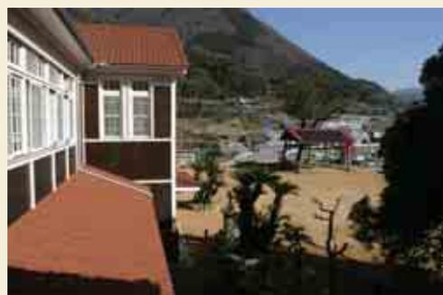
愛媛県内で現在最古の木造校舎。改修時に外壁は、セピア色の古い卒業アルバムの写真と周辺に住んでいる高齢者への聞き取り調査などをもとに、竣工当時のものを再現したかたちで、県内産のスギ板下見板張りに木材保護塗料仕上げとされた。(左) 東側外観、(右) 木製のサッシ
