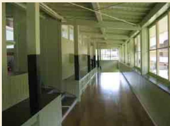
教室の両面採光を確保するため、廊下の天井を低く抑え、左手にある光庭に、光が入りやすいよう工夫されている。
