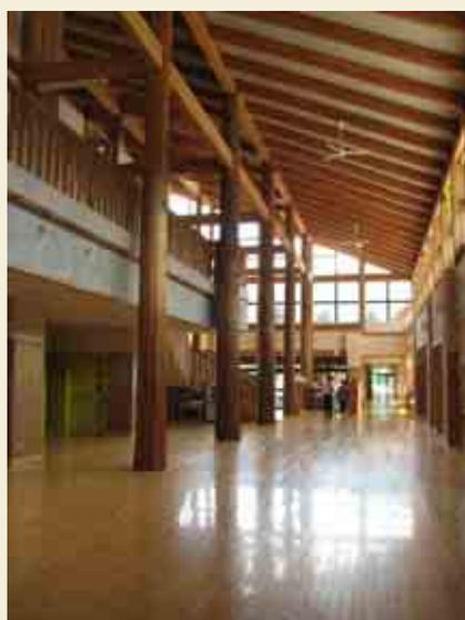
学校を支える柱として、町有林のスギが活用されている。2 層吹抜のホールには直径 50cm、長さ 10 ~ 12m の磨き丸太 11 本が使用されている。
