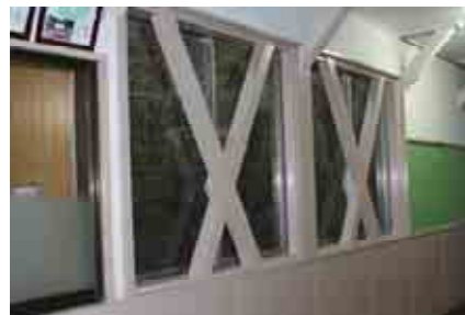
筋交いによる壁補強（追分小学校）
