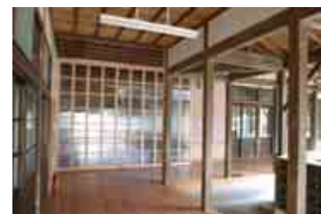
開放廊下の冬季対策としての開放階段室前の可動間仕切
