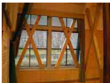
筋交いによる壁補強（足助小学校）
