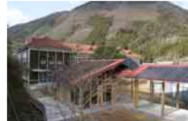
屋根材一体型太陽発電パネルの屋根と小型風力発電機
