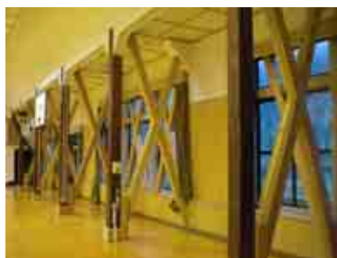
内壁内側柱に対する筋交い（足助小学校） 外部筋交いバットレス（足助小学校） 〔足助小学校〕
