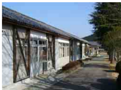
南棟西側外観
