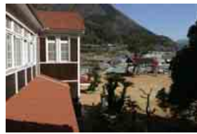
昭和の改修でアルミサッシになっていたものを、機密性の高い木製サッシに改修
