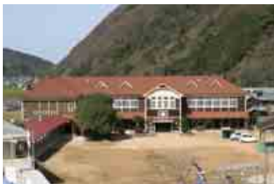
東側外観：県産のスギ板の下見板張りの外壁
