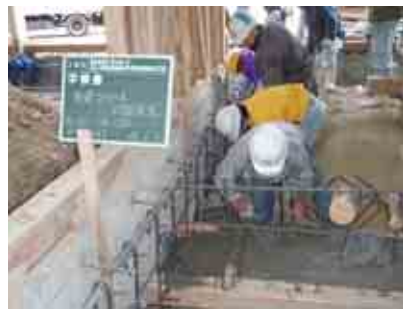
鉄筋コンクリート造の基礎の併設
