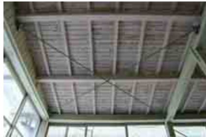
ブレースによる屋根補強
