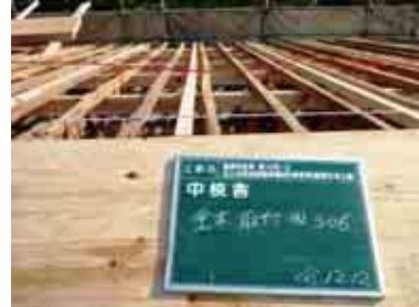
床の垂木・構造用合板による補強の施工状況
