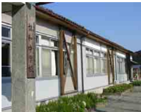
南棟東側外観
