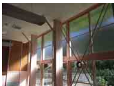
二重に配した丸鋼ブレース
