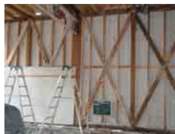
耐力壁補強の施工状況
