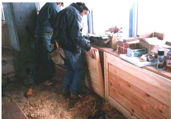
ハーフパネルの施工
