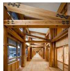
内部の木材継手状況
