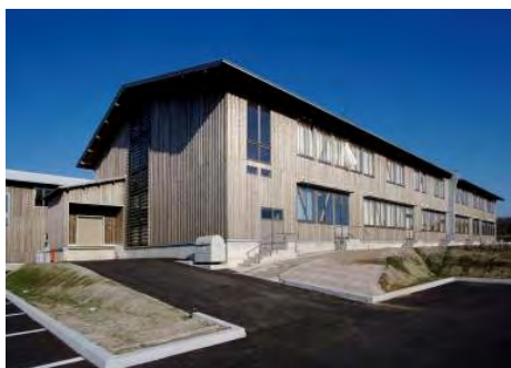
全面秋田スギ厚板張りの外壁
