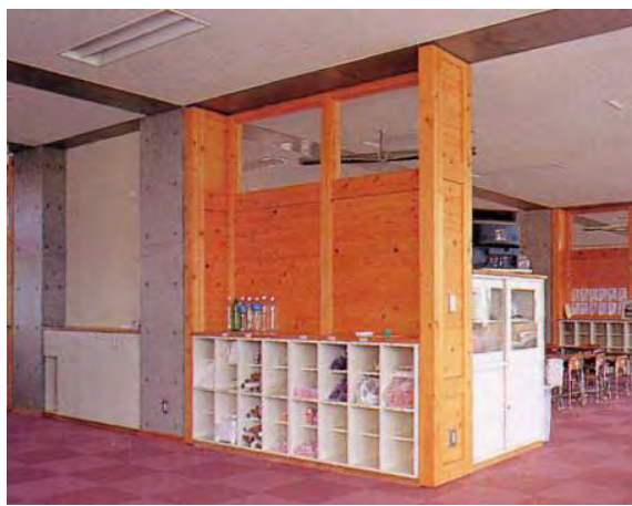
教室間とオープンスペースにしつらえられた木製インフィル
