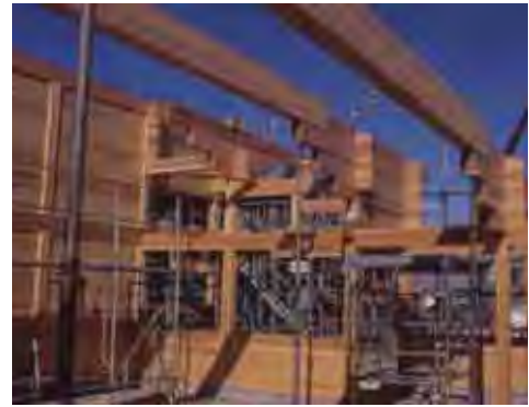
教室棟 持送り重ね梁と落込み板壁
