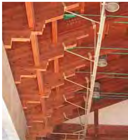
体育館の持ち送り重ね梁部分
