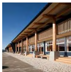
普通教室棟南面の軒先
