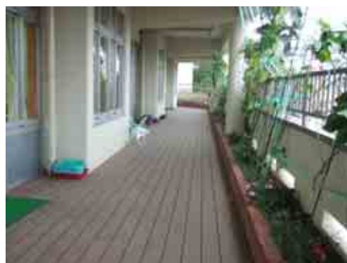
木製デッキのバルコニー 底があるので教室の温度変化を抑制し、騒音を低減する。
