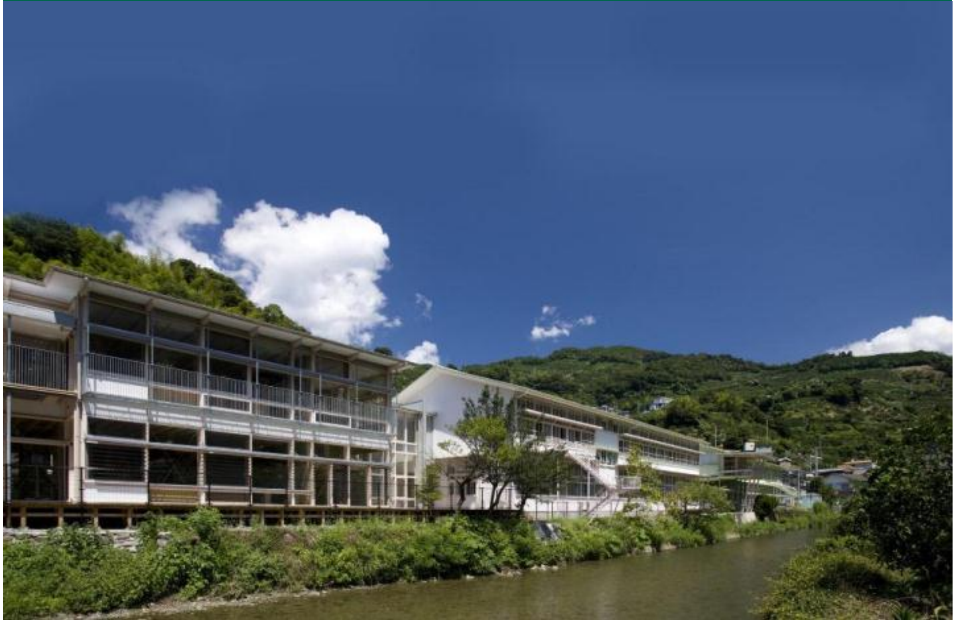
八幡浜市立日土小学校（1956-58/愛媛県）
