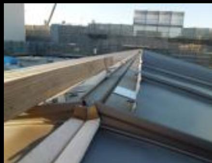
屋根鋼板裏 制振断熱シート裏張り
