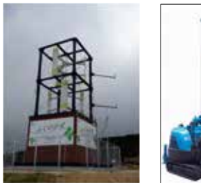
福島大学がコンソーシアムと開発した縦型5kW風力発電システム実証機
