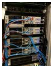
会津大学とコンソーシアムが開発したエネルギーマネジメントシステム
