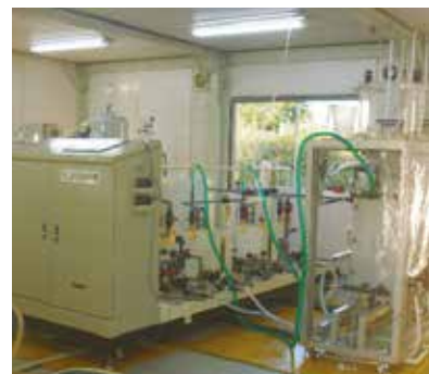
濃度差水素製造システム
