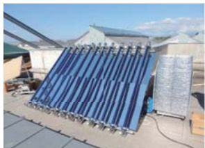
熱音響現象を利用した新しい発電システム(集熱部分)
