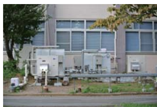
直膨方式地中熱ヒートポンプ(空調・給湯用)の大学実験サイト
