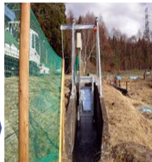
環境調和型ナノ水力発電システム 須坂市に4台のナノ水力発電システムと、スマートグリッド装置を導入し、実証試験を展開中。
