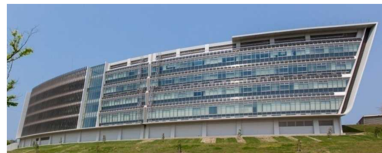
伊都キャンパス・イーストゾーンに施設建設
