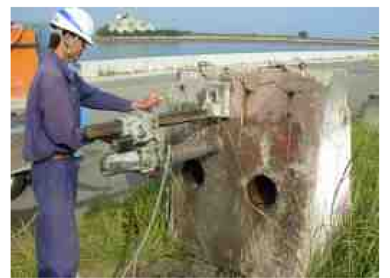
写真1 コンクリート試料採取風景
