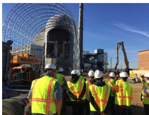
アメリカ・ラクロス原子力発電所 (H29 年度) 格納容器内解体準備作業現場を視察
