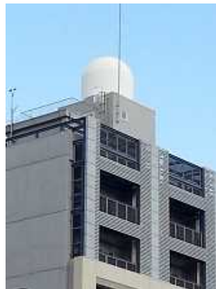
大阪大学に設置されたフェーズドアレイ気象レーダのドーム
