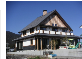
(株)日進産業が開発した「建築用塗布式断熱材」の施工事例
