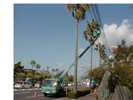
高所作業車での人力による作業
