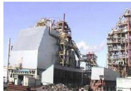
パイロットプラント (石炭処理量 6.0トン/h)
