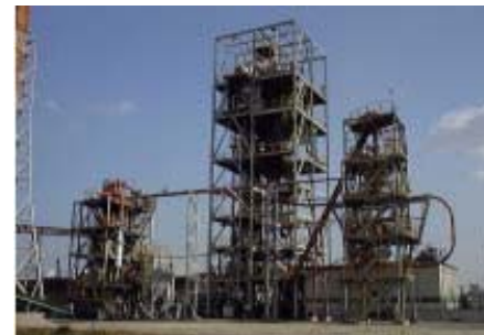
ベンチプラント (石炭処理量 0.6トン/h)
