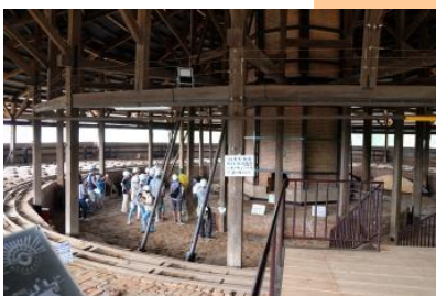
重要文化財（建造物） 旧下野煉化製造会社煉瓦窯（栃木県） 案内板の設置による解説
