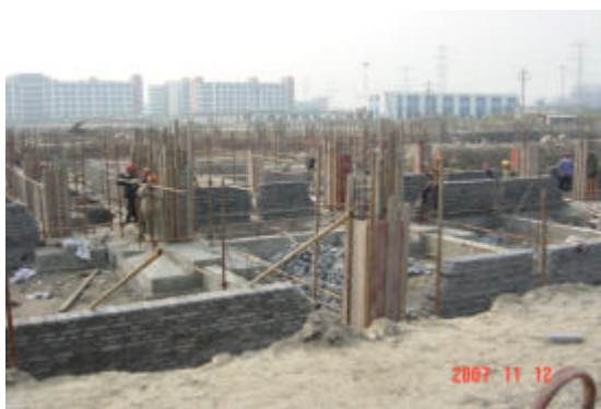
杭州日本人学校建設現場
