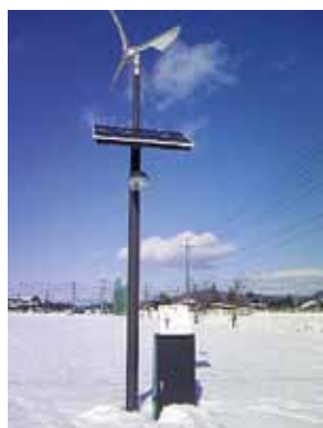
風力発電（矢巾東小学校）
