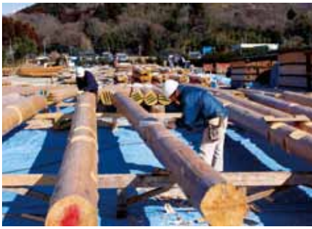
木材加工の現場
