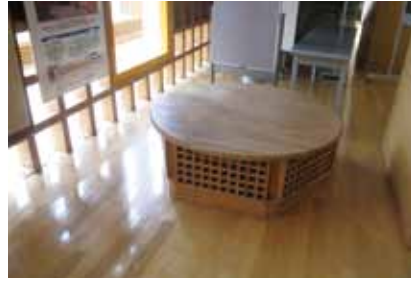
アースチューブ（左：吸気口、右：吹出口）
