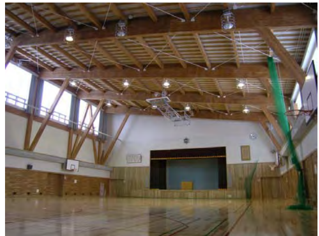
木材（集成材）利用した屋内運動場 （間伐材(カラマツ材)約1500本利用・地元産
