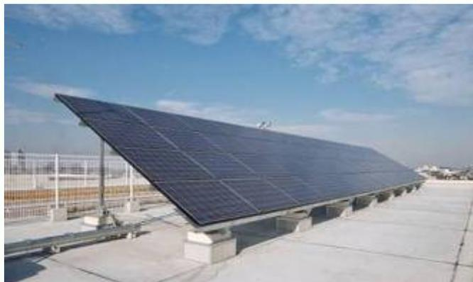
屋上に10kWの太陽光発電パネルを設置。
