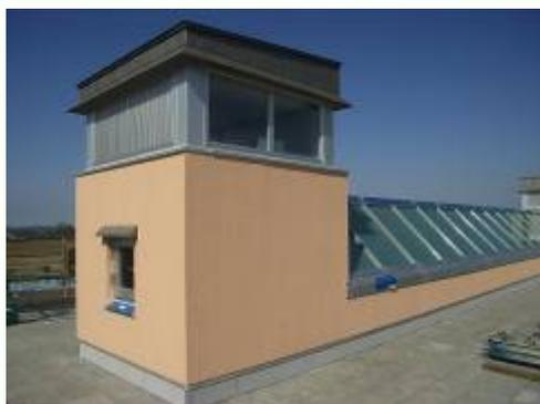
校舎中央吹抜け上部のトップライト両端に換気塔を設置し、冬期はトップライト部分に溜まった暖気をファンにより対流させる。
