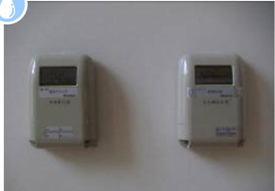
雨水利用設備については雨水と上水の利用状況を比較して見られるよう表示装置を生徒たちが必ず行き帰りに通過する昇降口付近に設置。
