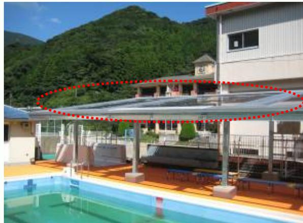
プールサイドに5kWの庇兼用太陽電池パネルを設置。
