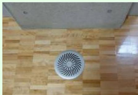
地中熱吹き出し口から昇降口及び校舎中央の吹抜けへ床下を通して給気している。
