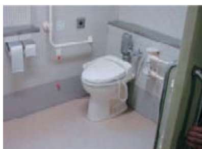
手すりを設けたトイレ
