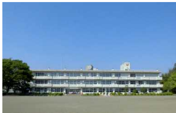
校舎等の外観写真
