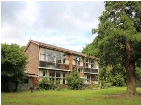
校舎等の外観写真
