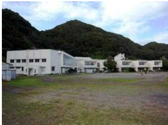
校舎等の外観写真
