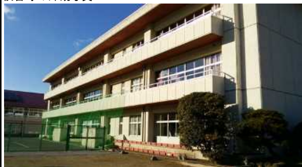
校舎等の外観写真
