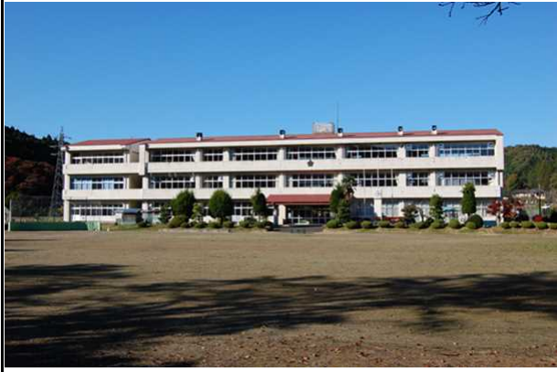
校舎等の外観写真
