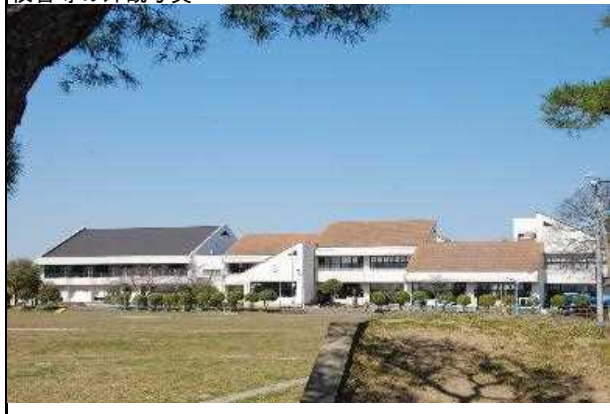
校舎等の外観写真
