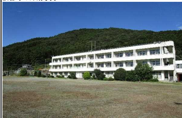
校舎等の外観写真
