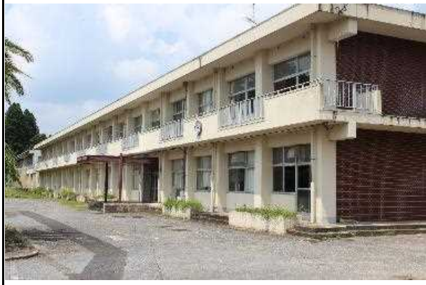
校舎等の外観写真
