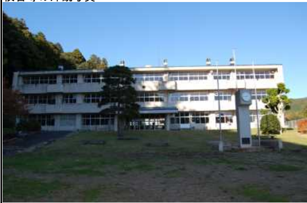
校舎等の外観写真
