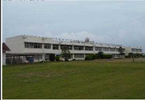
校舎等の外観写真
