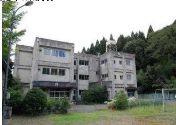
校舎等の外観写真
