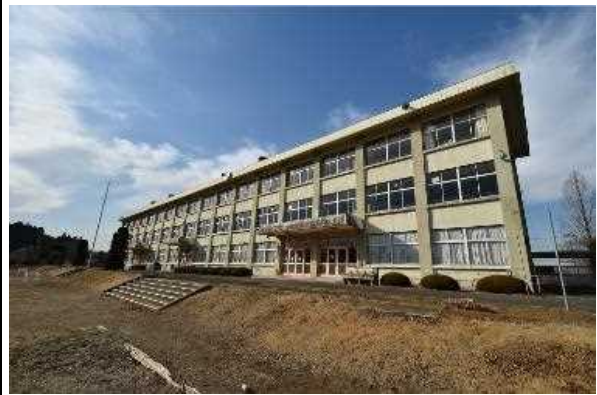
校舎等の外観写真
