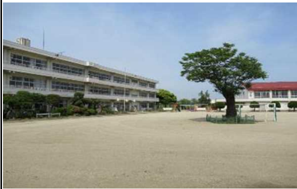
校舎等の外観写真
