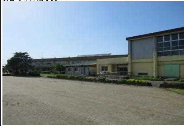
校舎等の外観写真
