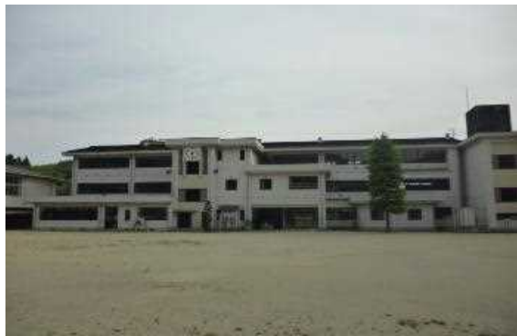
校舎等の外観写真
