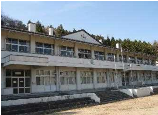
校舎等の外観写真
