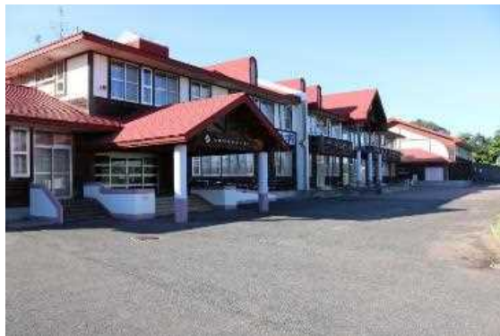
校舎等の外観写真
