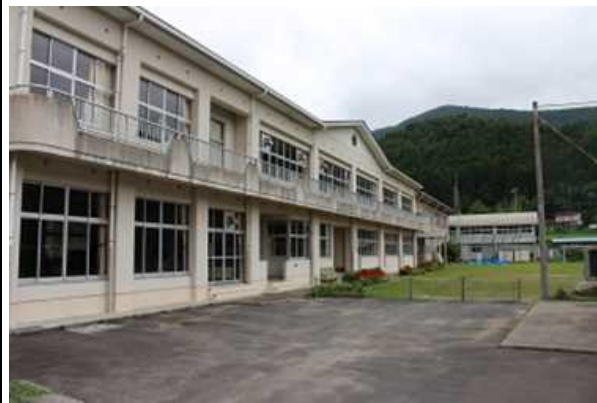
校舎等の外観写真
