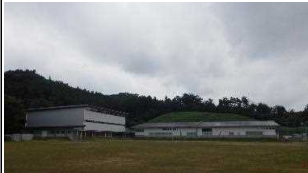
校舎等の外観写真
