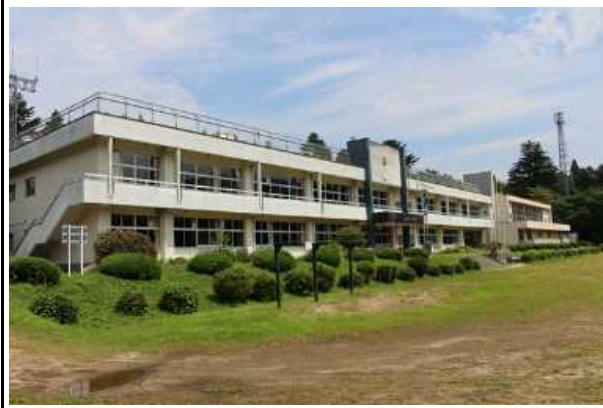
校舎等の外観写真
