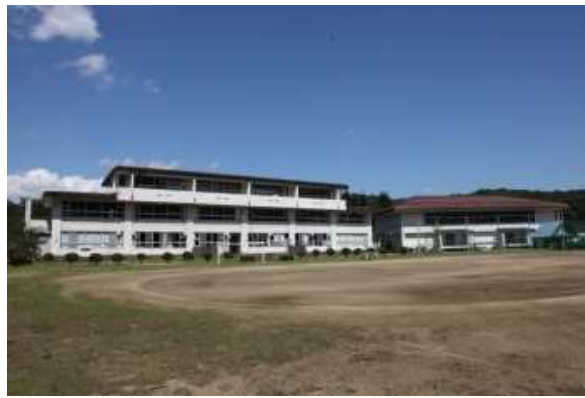
校舎等の外観写真
