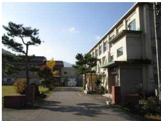
校舎等の外観写真
