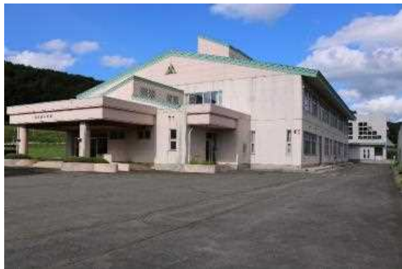
校舎等の外観写真
