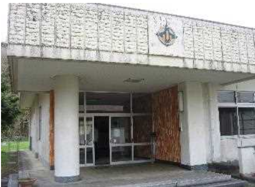
校舎等の外観写真
