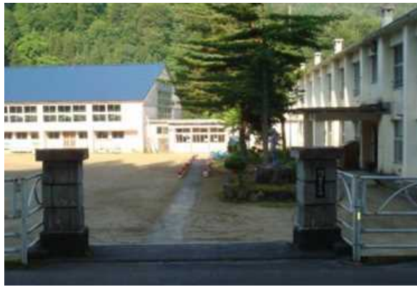
校舎等の外観写真
