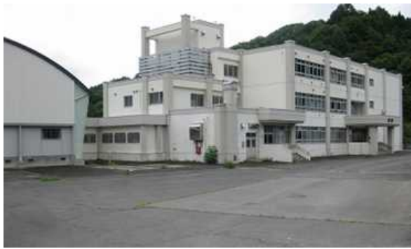
校舎等の外観写真
