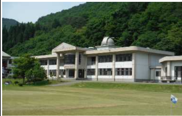
校舎等の外観写真
