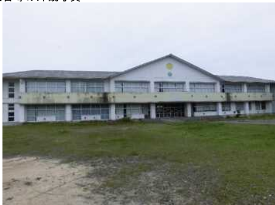
校舎等の外観写真
