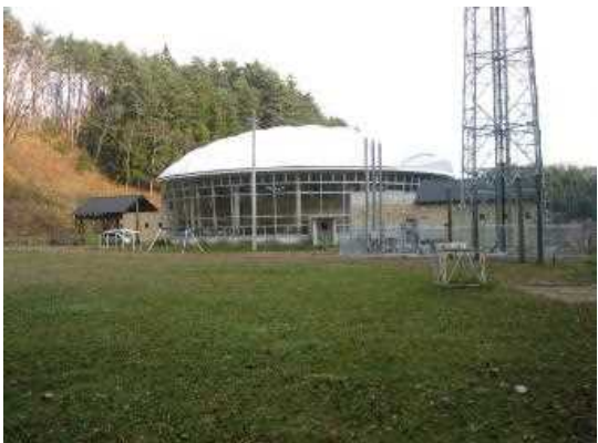
校舎等の外観写真
