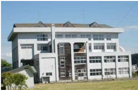
校舎等の外観写真
