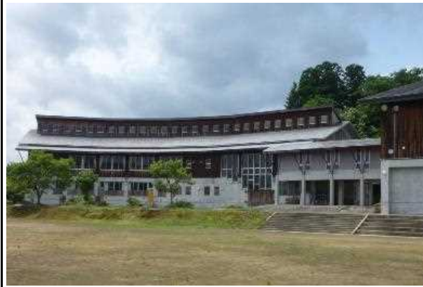
校舎等の外観写真
