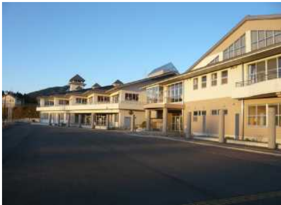
校舎等の外観写真
