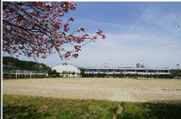
校舎等の外観写真
