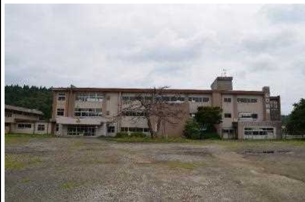
校舎等の外観写真
