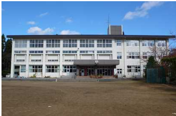
校舎等の外観写真
