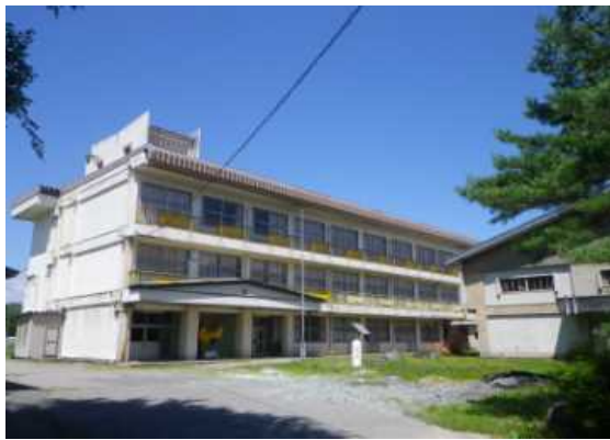
校舎等の外観写真
