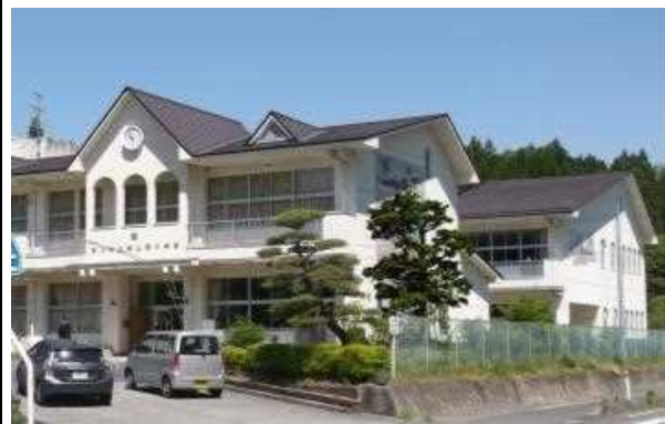
校舎等の外観写真
