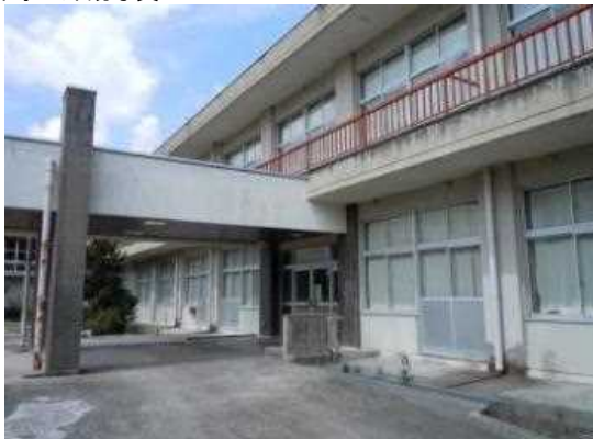
校舎等の外観写真
