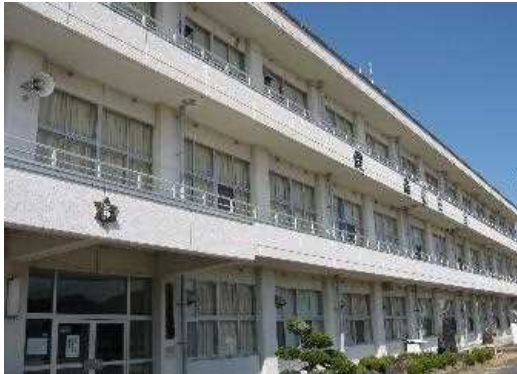
校舎等の外観写真
