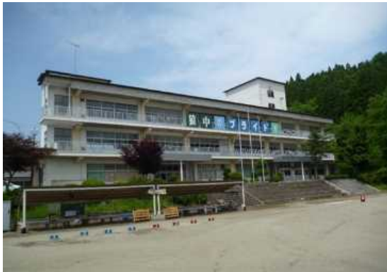
校舎等の外観写真
