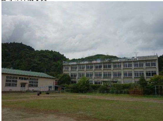
校舎等の外観写真
