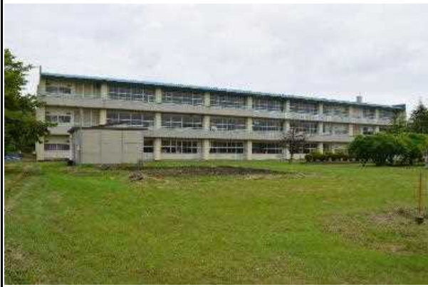
校舎等の外観写真
