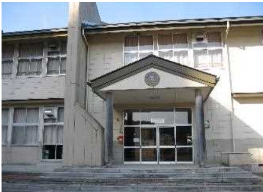
校舎等の外観写真
