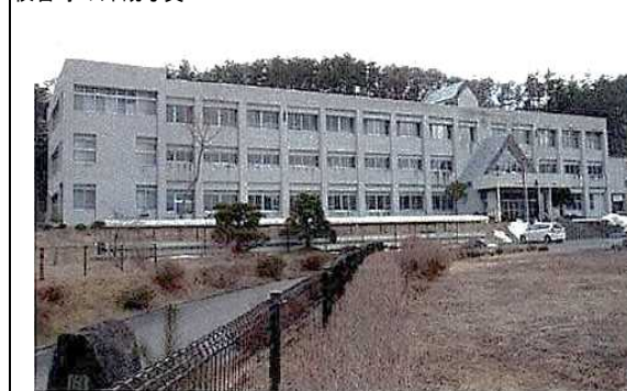
校舎等の外観写真
