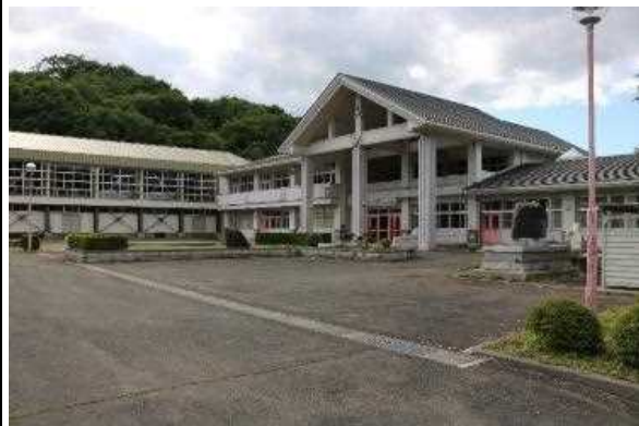
校舎等の外観写真
