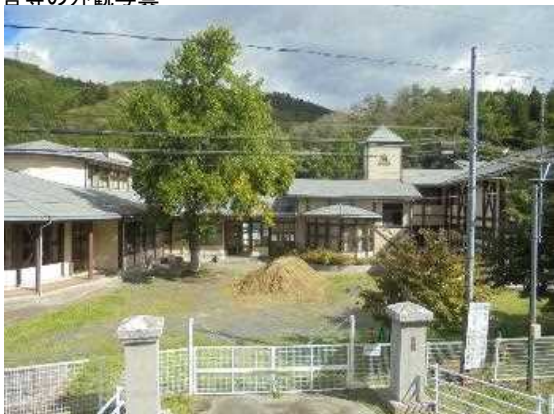
校舎等の外観写真
