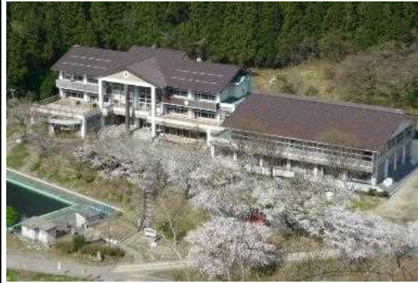
校舎等の外観写真
