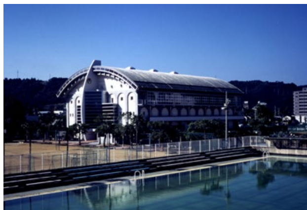
図 1 高知学芸高等学校創立 50 周年記念体育館外観 写真提供：上田建築事務所
