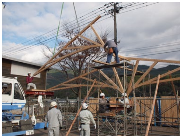
図 21 製材所で行われたモックアップ
