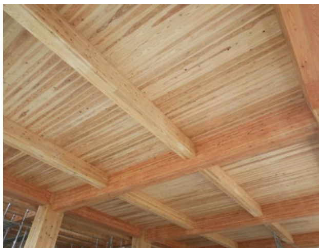
図 17 CLT 部施行中の様子
