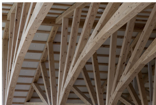
図12 地元大工により美しく組まれた架構
