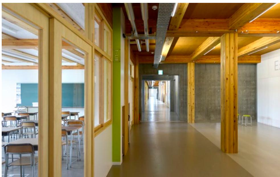
図 7 普通教室前の廊下と設備配管
