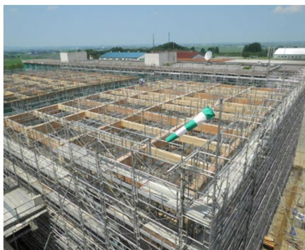
図 10 木造建て方終了時の状況
