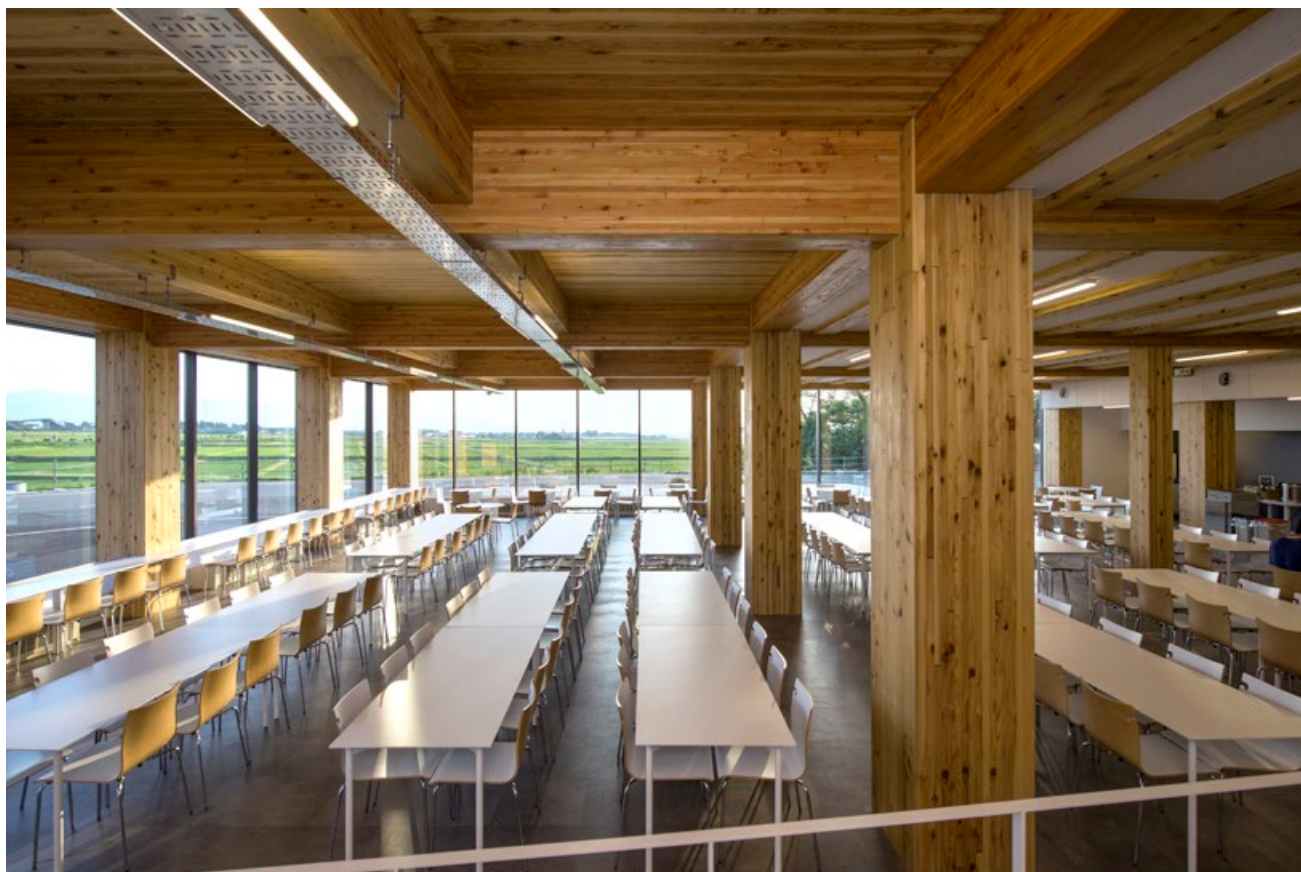
図 19 CLT が表しとなっているカフェテリア内観
