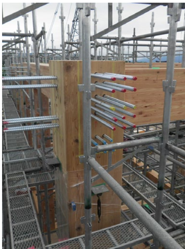
図 9 鉄筋挿入接着接合
