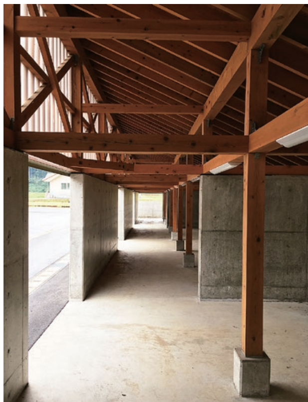
図 3-31 木質化された駐輪場
