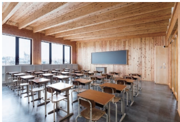
図3-6 CLTパネル工法を用いた郡山ヘアメイクカレッジ校舎
