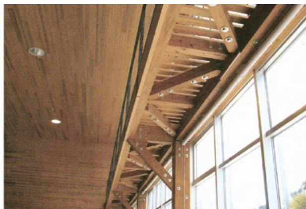
図 4-58 同庁舎の内観（内部は木質系材料を多用） 7)
