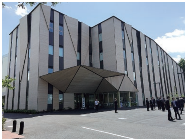
図 3-1 メンブレン型耐火木造による桐朋学園 4 階建木造校舎
