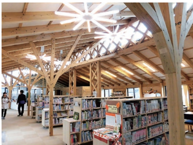
図 3-16 東松島市立宮野森小学校の図書室の樹状方杖架構
