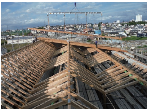
図 4-4 モックアップによる検討 (上) 施工時の様子 (下)
