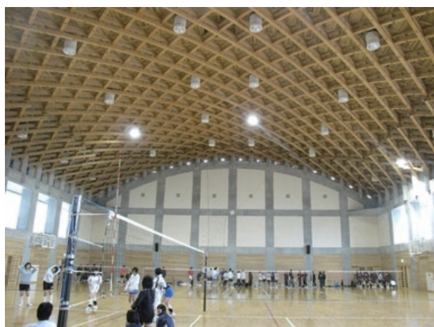
図4-45 耐火性能検証により耐火建築物として大臣認定を取得した体育館（高知学芸中学高等学校記念体育館）
