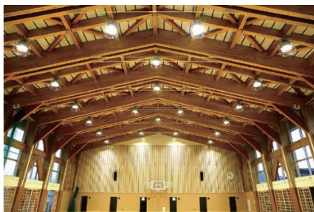
図 4-10 通直集成材を用いた体育館（浜松）（静岡県立天竜高等学校）
