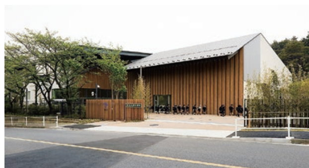
図 3-29 木質化された外壁
