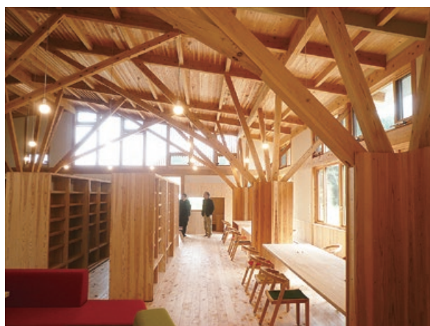
図 3-15 愛農高校森館図書室の県産スギ製材による樹状方杖架構
