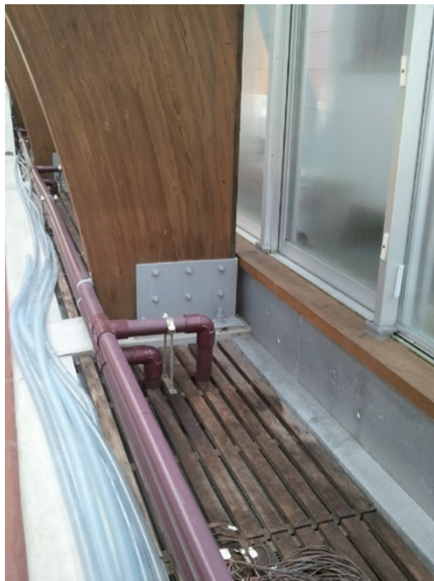
図 4-62 同プールにおいて外壁サッシ面に結露が発生しにくいよう半地下部分にラジエーターが埋め込まれている
