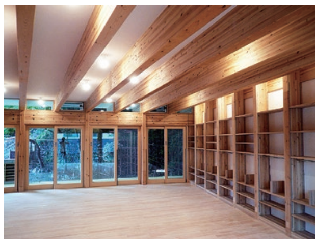
図 3-8 引きボルト式木造ラーメンを用いた日野わかさ幼稚園
