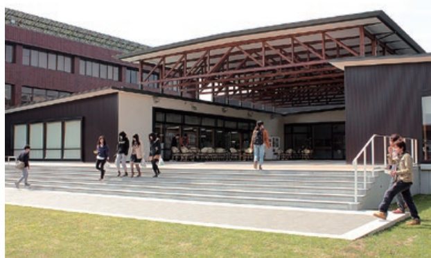
図 3-12 木造平行弦トラスを用いた宮崎大学創立 330 記念交流会館
