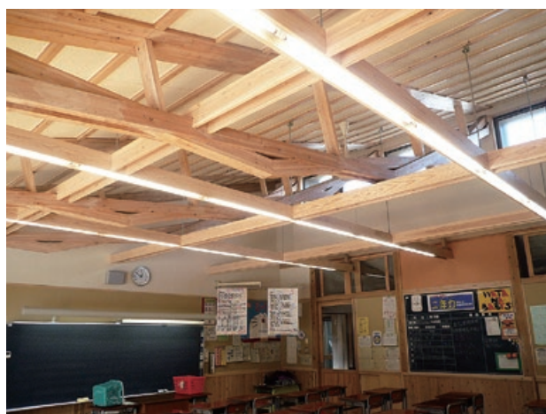
図 3-14 下弦材をシザース状とした弓形張弦トラス（沼田中学校）
