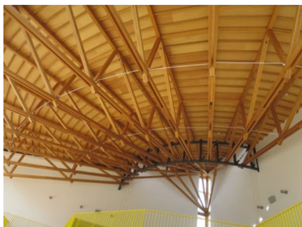
図 5-14 構造用製材で構成される多目的ホールの屋根
