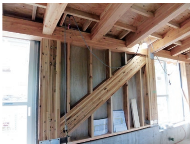
図3-7 釜石市立唐丹小中学校の大断面集成材ブレースの施工
