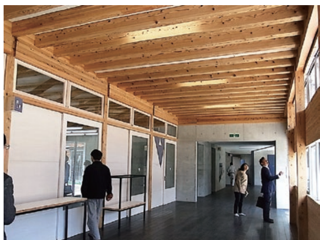
図 3-9 2階床を集成材の単純梁形式とした鹿北小学校の1階廊下
