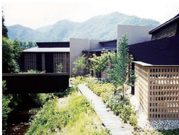
図 3-4 壁タイプの防火壁を用いた岐阜森林文化アカデミーの校舎
