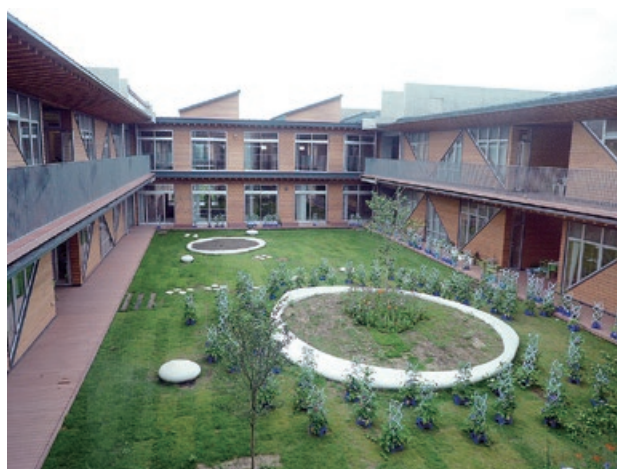
図 3-5 別棟通達とコアタイプの防火壁を用いた陽光台小学校
