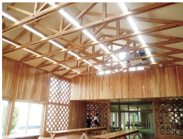
図 3-11 木造キングポストトラスを用いた松前中学校ランチルーム
