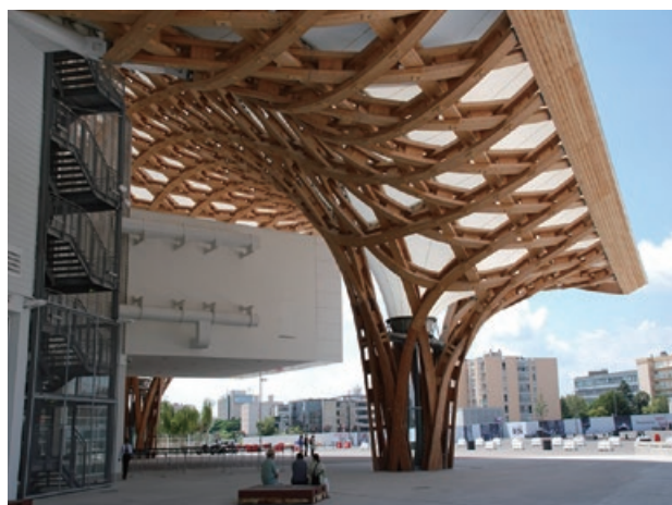
図 4-11 RC と木造シェル構造の美術館（フランス）（ポンピドー・センター，メッツ）
