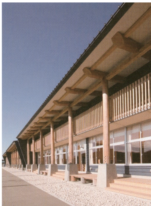
図 4-59 軒樋を省き基礎高を高くしてメンテナンスコストの抑制に配慮した中学校校舎 7)
