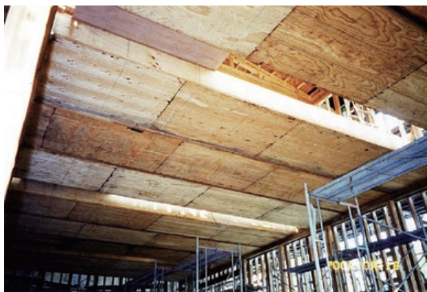
図 3-10 森林文化アカデミーの2階床 LVL ストレストスキンパネル
