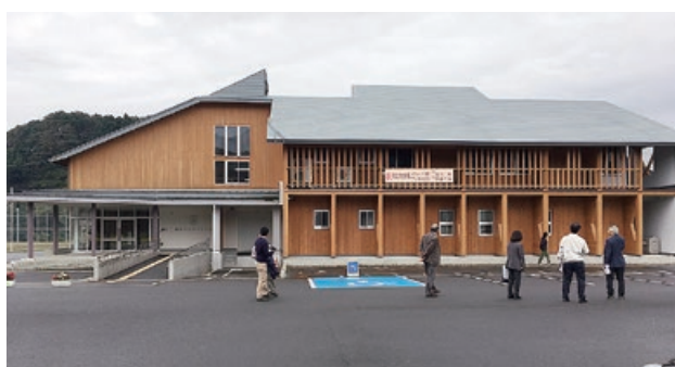
図 3-30 木質化された外壁
