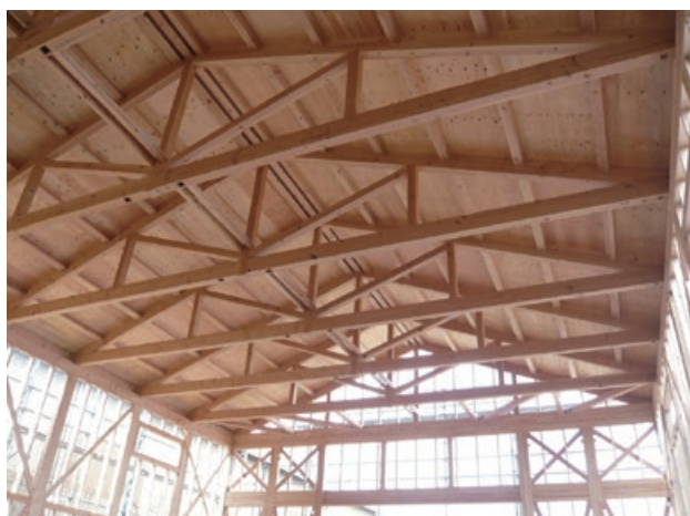
図 4-24 小屋組トラスを用いた空間の例
