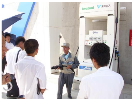
写真8 水素ステーションのシステムを学ぶ生徒
