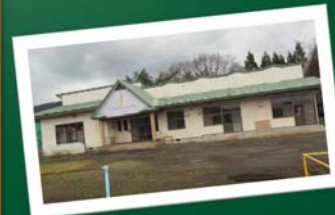
平成21年に閉所され、放置状態の公共施設(保育所)
